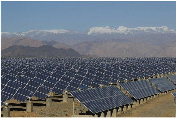
Les panneaux solaires sont utilisés pour alimenter en électricité des sites isolés et difficiles d'accès, par exemple des régions montagneuses. Dans ces cas, il est intéressant d'installer des panneaux solaires car ceux-ci ne demandent que très peu, voir aucun entretien.
